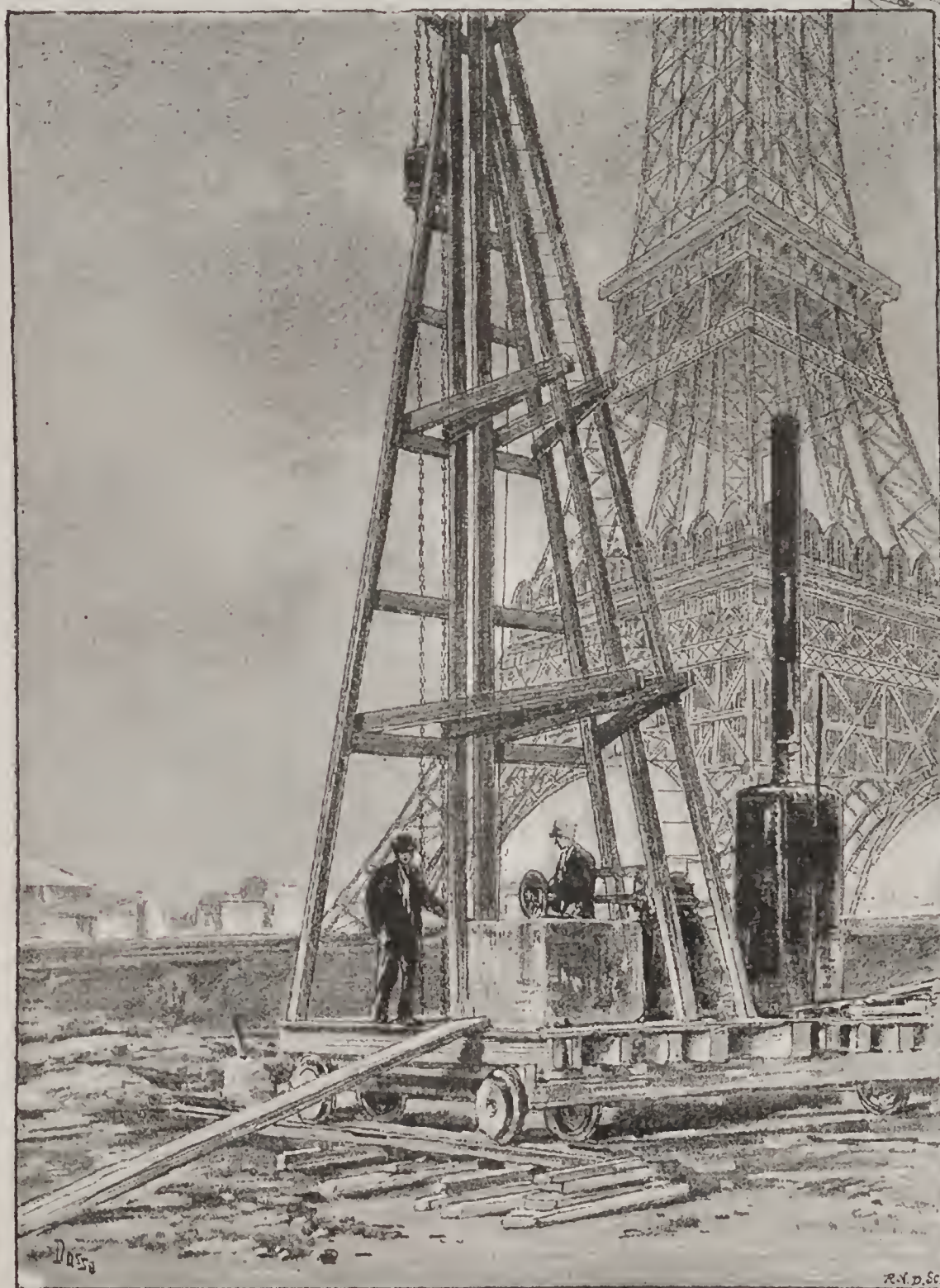
PROCÉDÉ DE FONDATION ÉCONOMIQUE. — Sonnette à pilon, fonctionnant près de la tour Eiffel.
